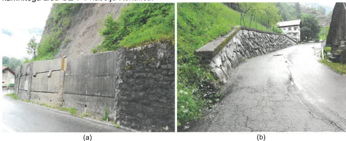
Slika 4: (a) Pogled na oporni konstrukciji OZ-5 in OZ-6 (b) Pogled na območje zaključka rekonstrukcije ceste pred mostom preko Koritnice z oporno konstrukcijo OZ-7
